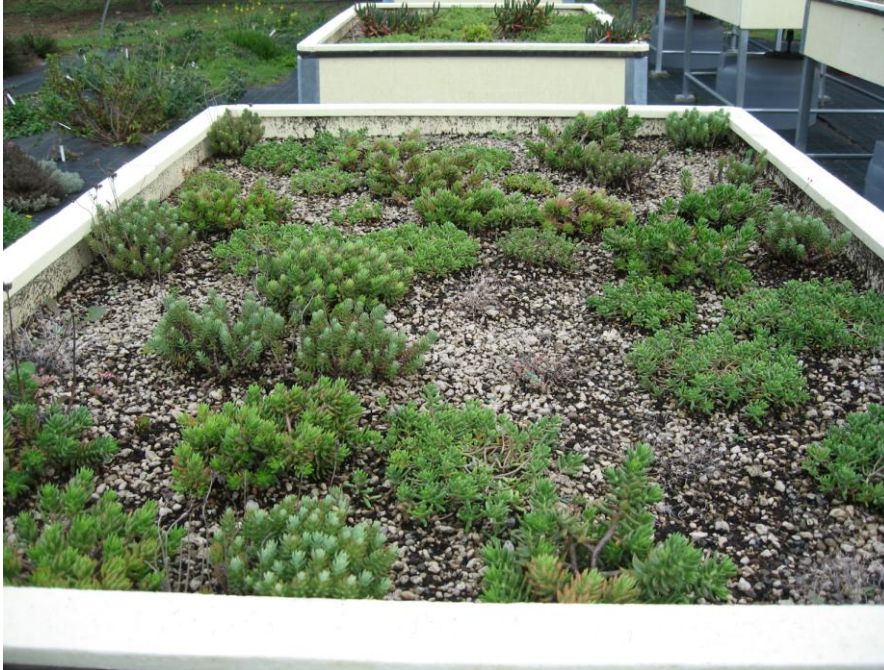
Figura 21. La copertura di Sedum 15 mesi dopo l'impianto
