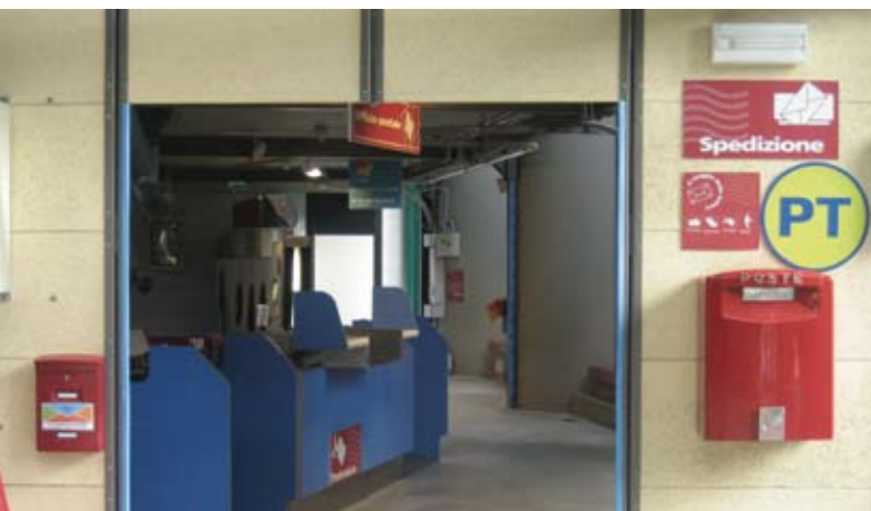
22. Soglia di ingresso alle poste.
