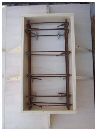
**Fig. 2-4 - Posizionamento delle armature all'interno delle casseformi.**
