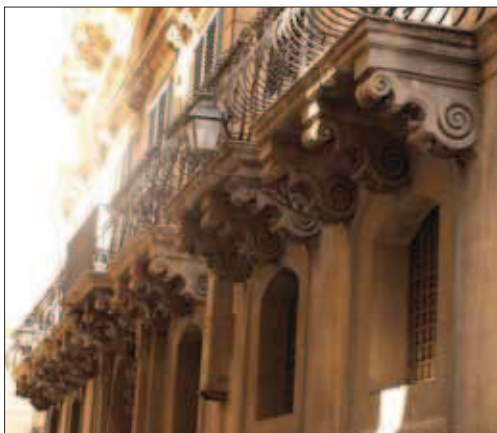
Fig. 7 – Palermo, Palazzo San Marco-Mirto , prospetto su via Lungarini, sequenza delle mensole del piano nobile.
