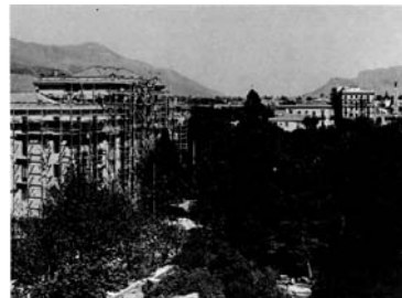
L. Epifanio, G.B. Santangelo, Quartiere Giardino del Littorio (poi G. Matteotti), via Libertà, Palermo, 1927-1932. Il quartiere in costruzione (IACPDoc).
