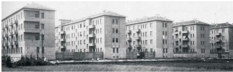
Quartiere Lontereggio, Milano 1938-44. Veduta del quartiere (R. Pugliese, 2005).
