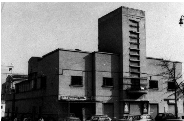
A. Pollaci, Casa Rionale del Fascio, oggi Cinema Edison, piazza Colajanni, Palermo. Veduta dalla piazza (I.A. Provenzano, 1984).
