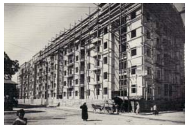
G.B. Santangelo, lotto X, corso Tukori, Palermo, 1934. Il fabbricato in costruzione (IACPDoc).
