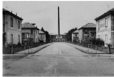
Veduta panoramica Nord-Ovest delle abitazioni, 1890-1915 (R. Gabetti, 1981).
