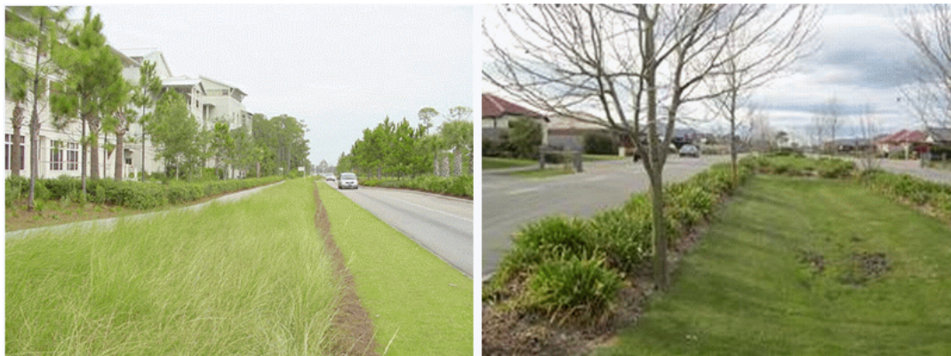
Figura 2 - Esempi di cunetta erbosa
