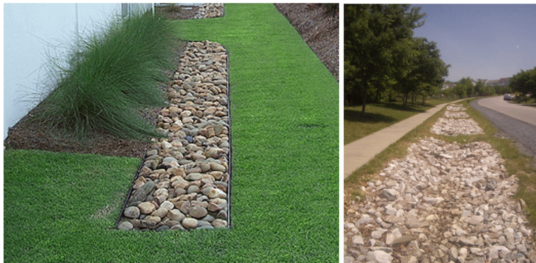
Figura 11 - Esempi di trincee di infiltrazione
