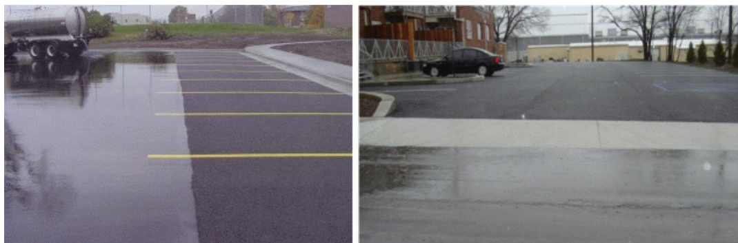
Figura 15 – Esempi di pavimentazione in asfalto poroso confrontate con asfalto tradizionale
