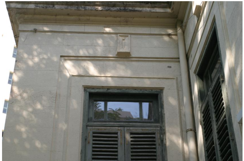
Dispensario Diurno (1920-28), E. Basile, Palermo; foto dell'apertura in legno con sovrastanti vetrini, del Sanatorio inquadrata da una cornice che si proietta sino alla parte basamentale
