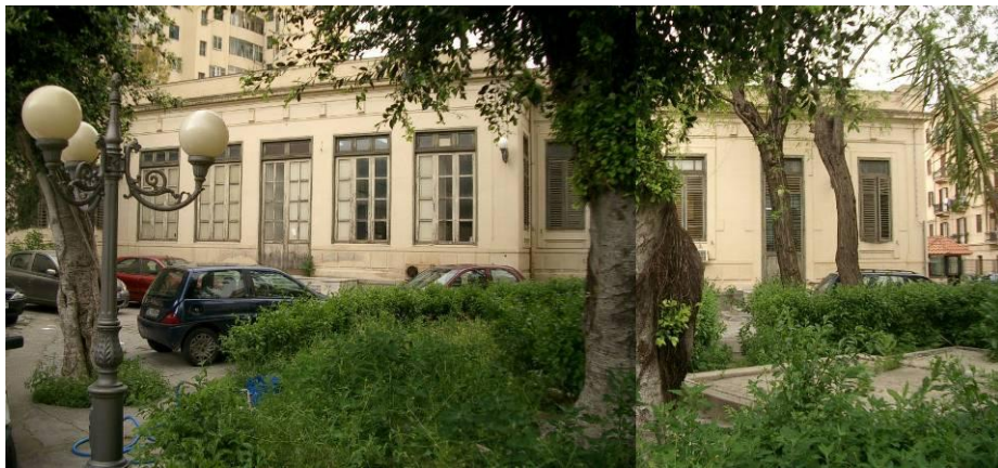
Dispensario Diurno (1920-28), E. Basile, Palermo; foto attuale del prospetto meridionale del Dispensario dal quale emerge il corpo-veranda prospiciente il giardino
