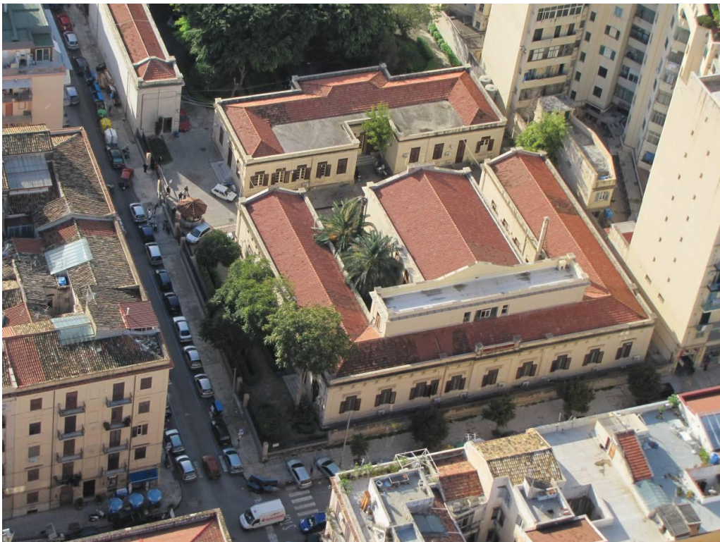
Dispensario Diurno (1920-25) di via Giorgio Arcoleo, progetto di E. Basile; foto aerea da est e da nord-est
