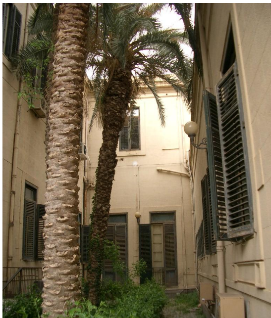
Dispensario Diurno (1920-28), E. Basile, Palermo; vista dello spazio delimitato tra l'ala destra e il corpo centrale del Dispensario su cui si affacciano ingressi secondari
