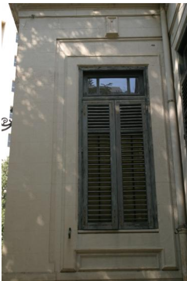
Dispensario Diurno (1920-28), E. Basile, Palermo; foto dell'apertura in legno con sovrastanti vetrini, del Sanatorio inquadrata da una cornice che si proietta sino alla parte basamentale
