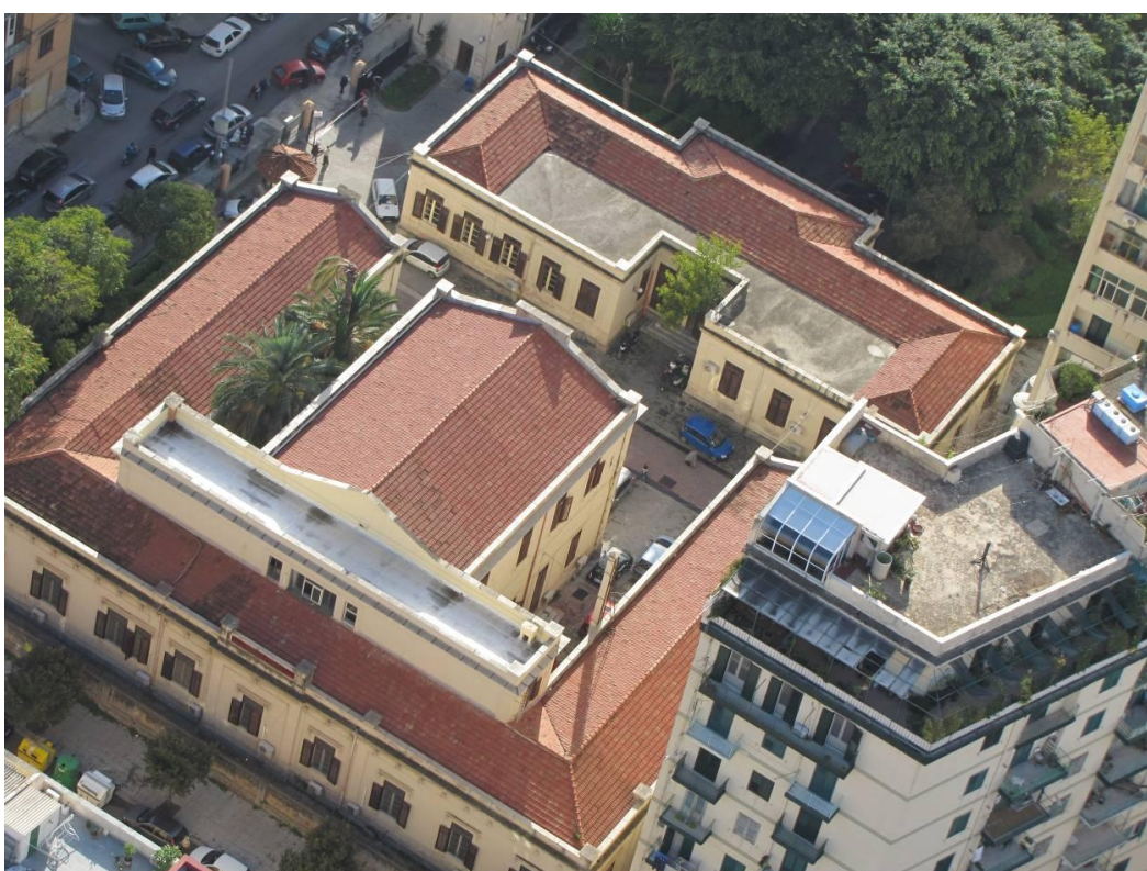
Dispensario Diumo (1920-25) di via Giorgio Arcoleo, progetto di E. Basile; foto aerea dell'intero complesso in direzione nord e sud
