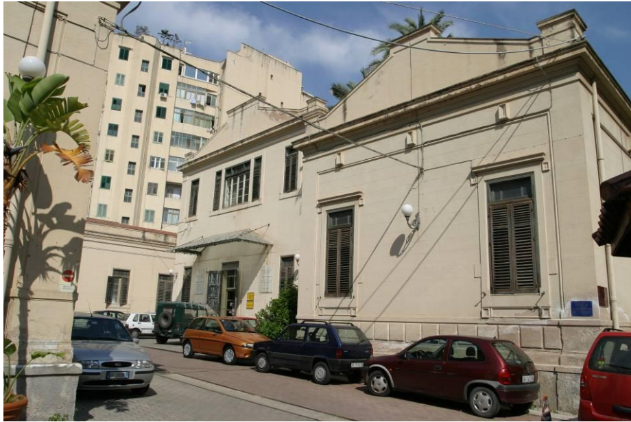
Dispensario Diurno (1920-28), E. Basile, Palermo; foto attuale del prospetto meridionale del Dispensario
