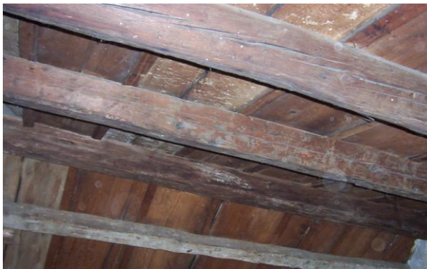
Dispensario Diurno (1920-28), E. Basile, Palermo; foto delle travi in legno della copertura del Dispensario visibili dal sottotetto
