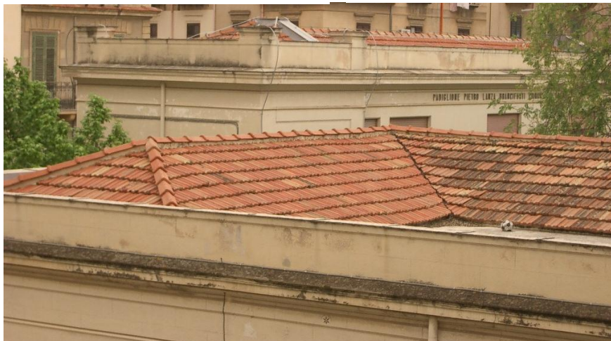
Dispensario Diurno (1920-28), E. Basile, Palermo; foto della copertura del Sanatorio
