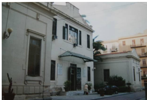
Dispensario Diurno (1920-28), E. Basile, Palermo; foto attuale del prospetto settentrionale del Dispensario
