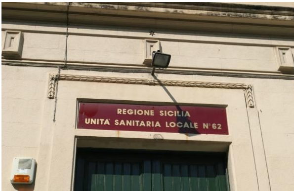
Dispensario Diurno (1920-28), E. Basile, Palermo; foto del particolare dell'elemento architettonico del "cordone" interrotto in mezzera da un elemento floreale, ubicato al di sopra della porta d'ingresso sul fronte occidentale
