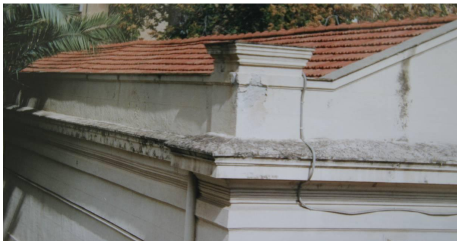
Dispensario Diurno (1920-28), E. Basile, Palermo; particolare del coronamento del Dispensario
