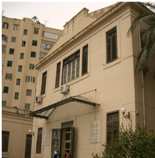
Dispensario Diurno (1920-28), E. Basile, Palermo; vista del corpo centrale del Dispensario
