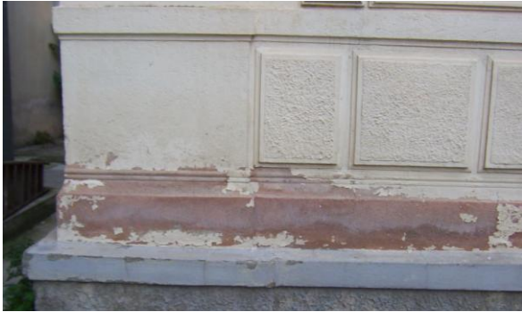
Dispensario Diurno (1920-28), E. Basile, Palermo; foto della parte basamentale del Dispensario che farebbe supporre, per la mancanza dell'intonaco, una coloritura rossastra dell'edificio.
