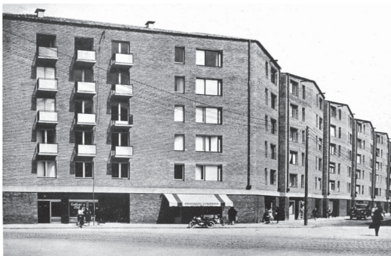
Fig.10: Il fronte su carrer Pallars in una foto d'epoca in cui si legge la suddivisione in blocchi.
