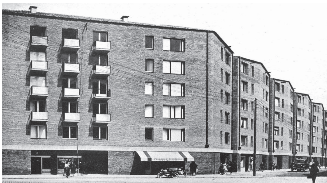
Fig.1: L'edificio di Oriol Bohigas e Josep Maria Martorell. Il fronte su carrer Pallars.
