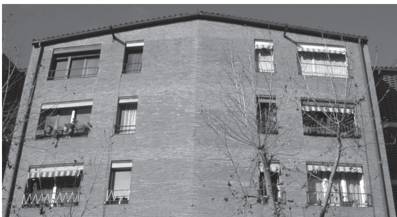
Fig.11: Un blocco del fronte su carrer Pallars con gli elementi metallici per il sollevamento dei pesi.
