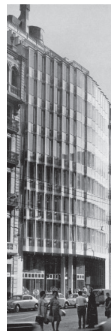
Fig.4: B.B.P.R., edificio della Hispano Olivetti, Barcellona 1960 – 64. Vista del fronte principale.
