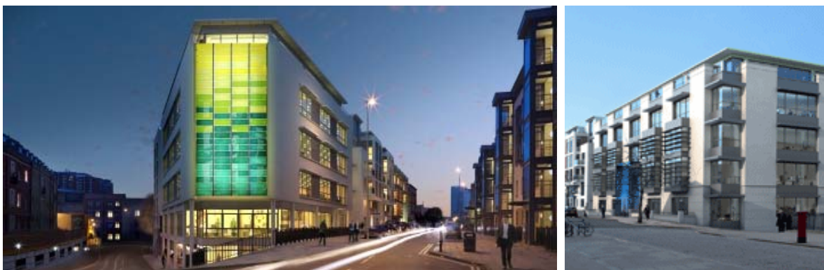
Figura 6.3 Horizon House a Bristol (UK), vincitore del BREEAM Award 2010 nella categoria uffici.
