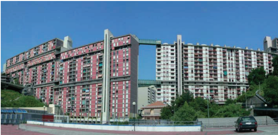
Fig. 2 - Genova, l'edificio chiamato Diga , nel quartiere Diamante, al confine tra i quartieri Rivarolo e Bolzaneto (da http://it.wikipedia.org/wiki/Rivarolo , consultato il 11/7/2013)
