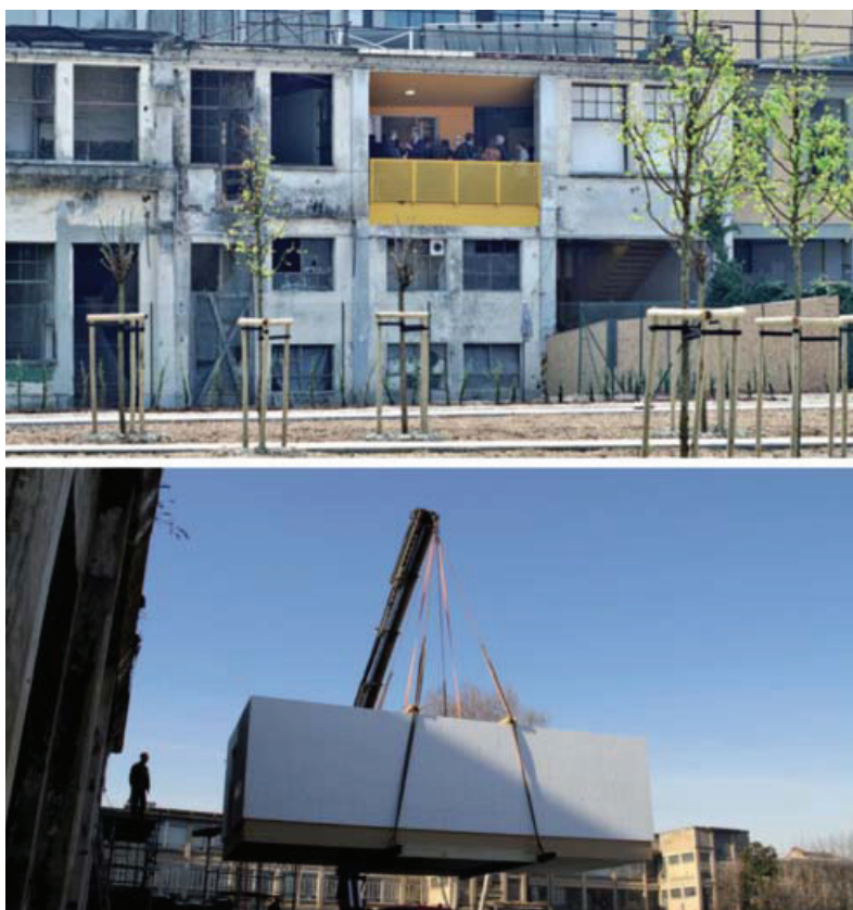
Fig. 5 - Prototipo CasaZero , modulo prefabbricato per il modello della Smart City di Torino (da http://www.casa24.ilsole24ore.com/art/mercato-immobiliare/2013-04-19/casazera-nuove-abitazioni-spazi-131607.php?uuid=AbFUEfoH , consultato il 11/7/2013)
