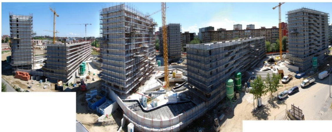
Figura 18: Immagine del cantiere iniziato nel 2008
