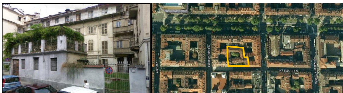
Figura 39: L'edificio e la sua localizzazione in fotoaerea
