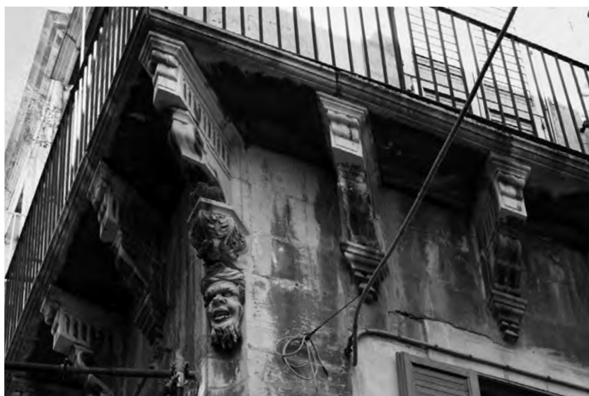
Fig. 15. Siracusa. Mensola oblique a sostegno del balcone angolare di uno dei palazzetti all'incrocio tra via Amalfitania e l'attuale via Cavour.
