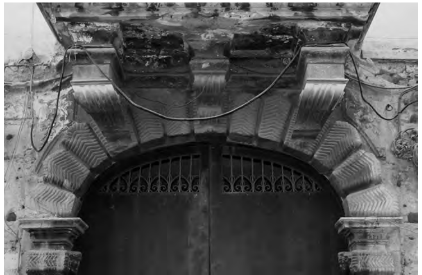
Fig. 16. Palermo. Palazzo Fileti Sammartino, particolare delle mensole del balcone che sormonta il portale.
