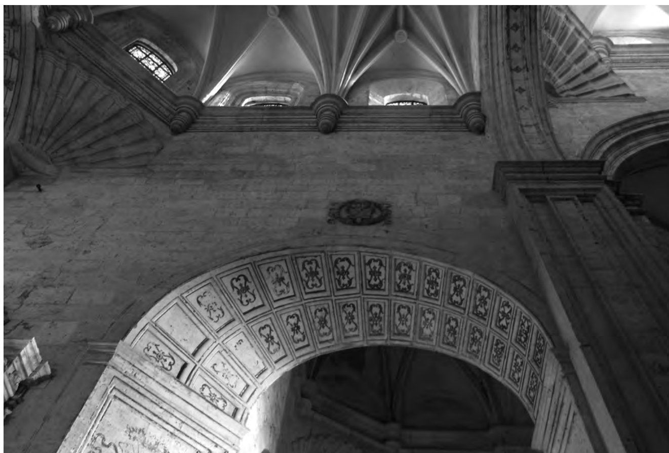
Fig. 3. Valladolid. Monastero della Santa Espina particolare di un arco obliquo all'interno della chiesa.
