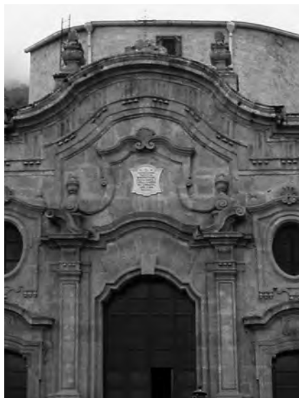
Figg. 12-13. Trabeazioni incurvate con triglifi obliqui: (a sinistra) Capaci, particolare del prospetto della chiesa madre; (a destra) Noto, dettaglio del balcone nel prospetto principale del convento di San Domenico (Rosario Gagliardi, 1727).
