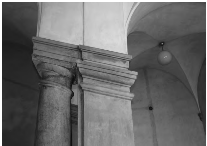
Fig. 7. Palermo. Collegio Massimo dei Gesuiti, scala (A. Italia, 1679-80), particolare dei capitelli obliqui.
