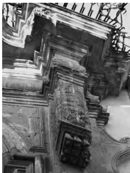
Fig. 14. Scicli. Palazzo Beneventano, particolare di una mensola obliqua sopra il portale.
