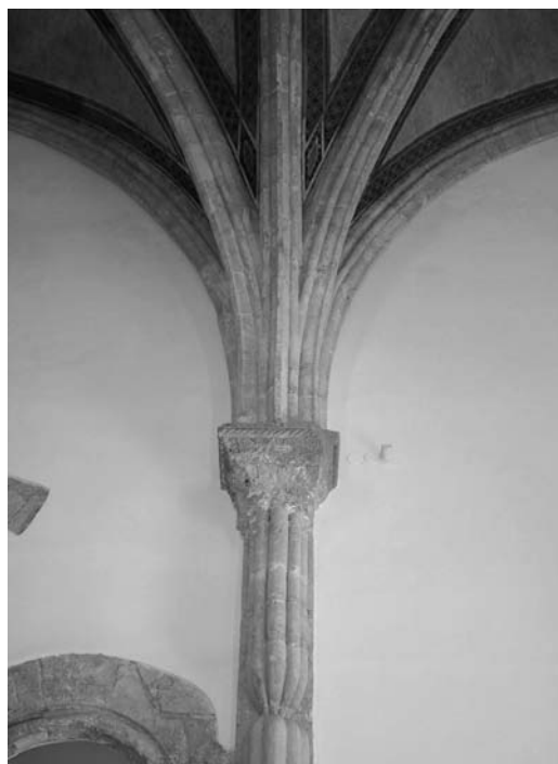
Figura 9 Detalle de una semi-pilastra central, con forma de «reloj de arena» y de la imposta de los nervios de los cruceros en la pequeña iglesia de San Antonio (foto de la autora 2013)
