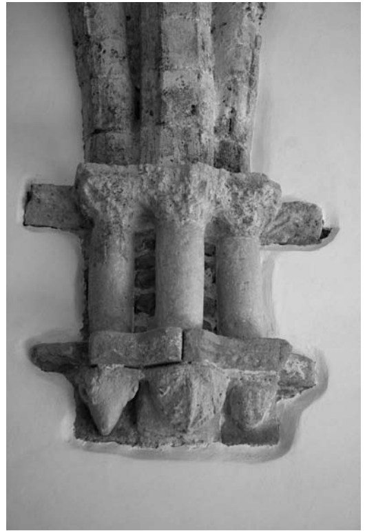
Figura 5 Detalles del apoyo del arco mediano y de los nervios de las bóvedas en la capilla dedicada a Santa Ana en el castillo de Geraci (P. Farinella 2009)
