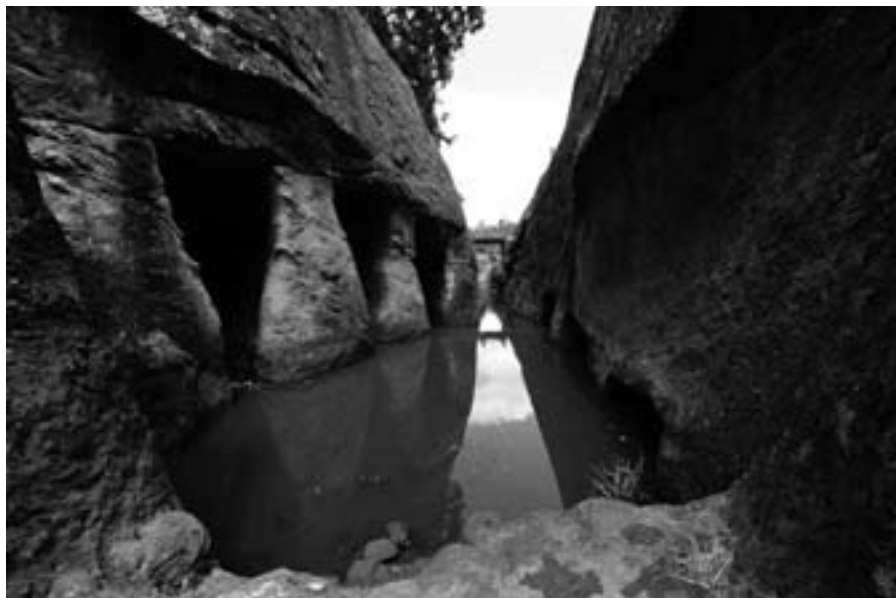
Lalibela, Etiopia: il restauro del sistema dei drenaggi realizzato dal progetto IPOGEO-ITKI ha protetto le chiese dall'umidità e permesso il recupero di antichi sistemi di raccolta di acqua. (Foto Pietro Laureano)
