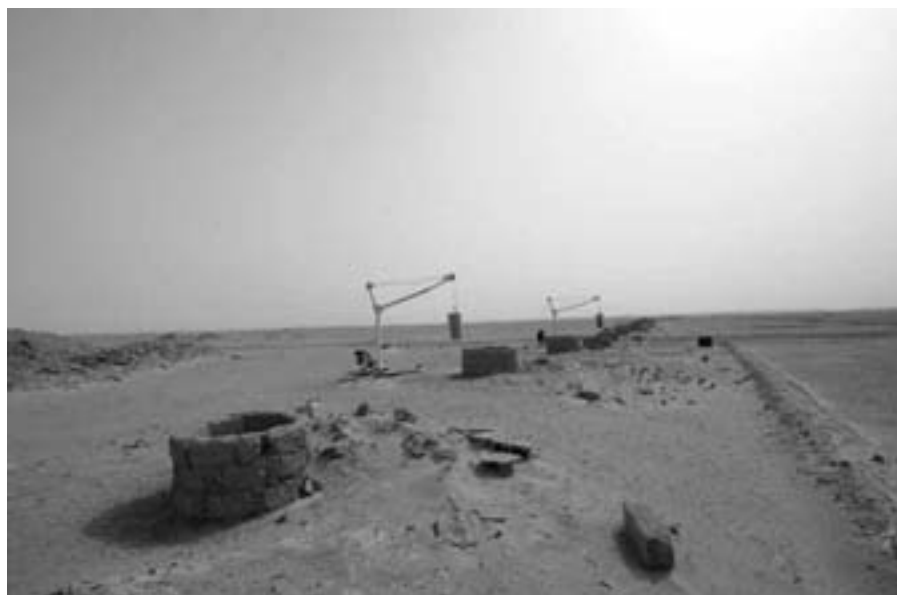
Amguid, Algeria: lavori di restauro di una gallerie di captazione idrica nel Sahara. (Foto Pietro Laureano)
