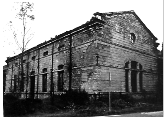
Figura 4: Centrale elettrica prima dei lavori di ristrutturazione
