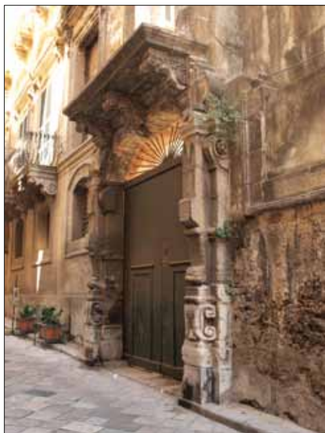
Fig. 5 – Palermo, Palazzo San Marco-Mirto , portale incompiuto del prospetto su via Lungarini
