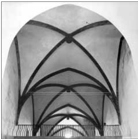
Fig. 5 – Palermo, Chiesa di Santa Maria della Pietà o del Portulano, particolare delle volte a crociera costolonate in una foto d'epoca
