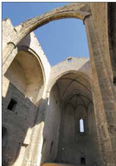
Fig. 3 - La chiesa di Santa Maria dello Spasimo oggi
