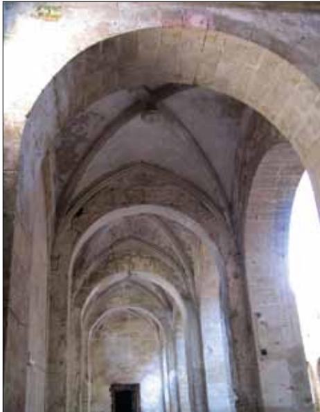
Fig. 1 – Palermo, Chiesa di Santa Maria dello Spasimo, particolare delle volte a crociera della navata laterale
