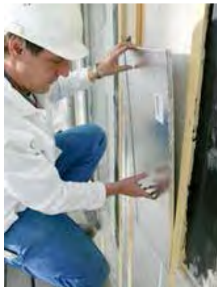
Fig. 3 – L'istallazione del Vacuum Insulation Panels.
