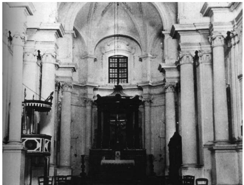
12. Partanna. Chiesa del Purgatorio, facciata prima del terremoto (da B. Patera, 1998).
