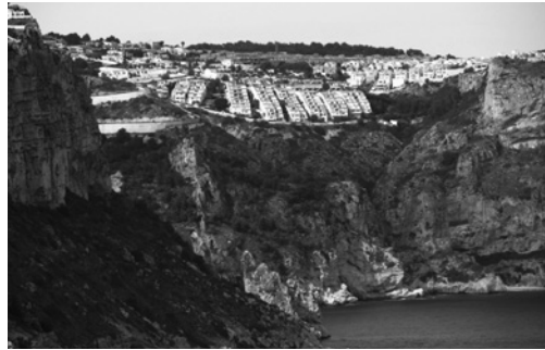
FIG. 15/ Agresión al medio ambiente. Hacinamiento de viviendas unifamiliares (dense sprawl) al borde de un acantilado, que además afea el paisaje de los acantilados del Morro del Castell (Benitatxell, Marina Alta, Costa Blanca)
