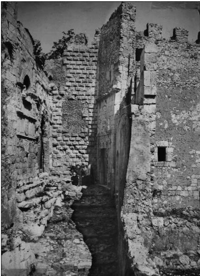
Fig. 1. Pietraperzia. Castello, seconda rampa d'ingresso (Biblioteca Comunale di Palermo (BCP), Fondo Valenti, 5 Qq E 185 n 4200002).
