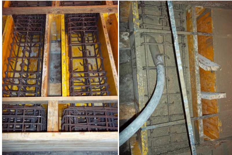
Figura 2.12 – Esecuzione delle colonne
