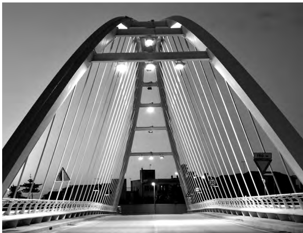
Mazara del Vallo, Ponte sul fiume Arena
