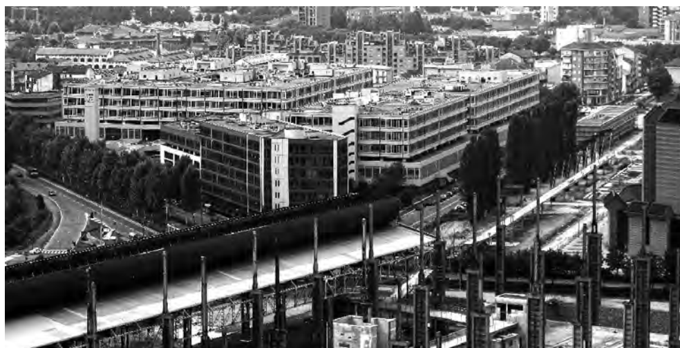
Torino - Cantiere dell'area Spina 3
