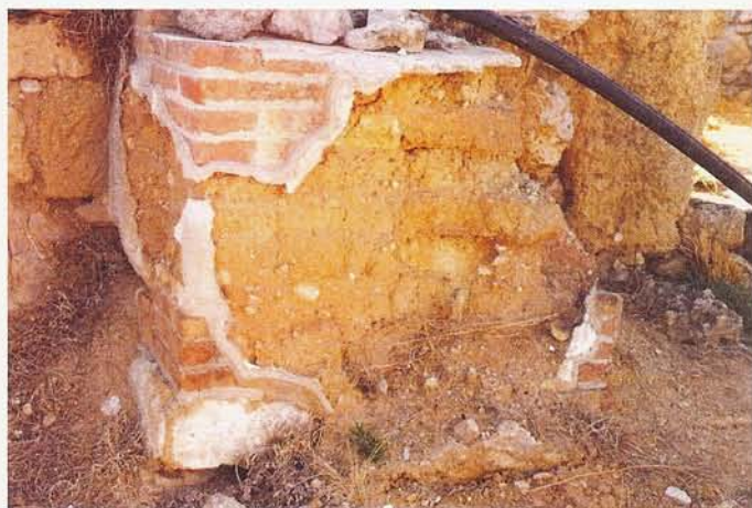
Solunto (Palermo). Vestiges d'adobe avec intégration de briques cuites et placage de ciment, en 1988 (F. Fernandez).
