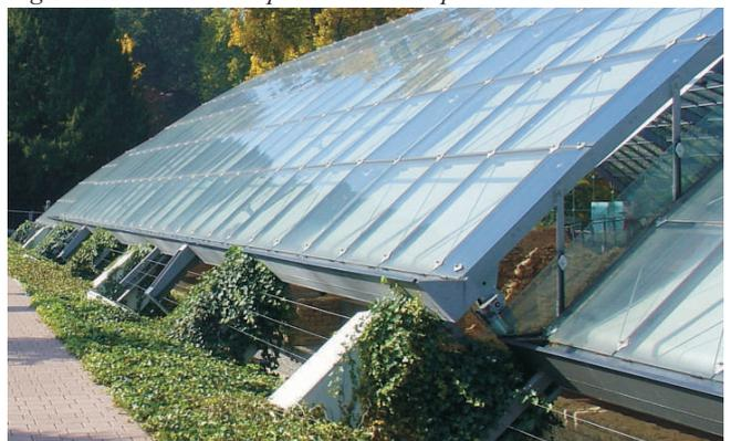
Fig.2 Vista esterna dell'apertura in basso per la ventilazione.
