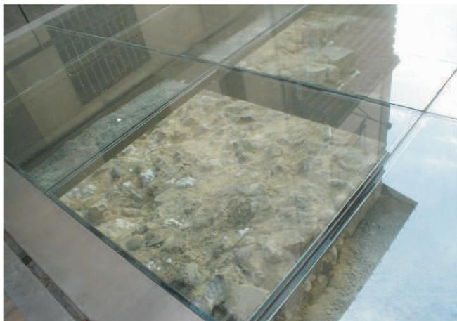
Fig.3 Vista delle lastre in vetro con giunti in silicone.
