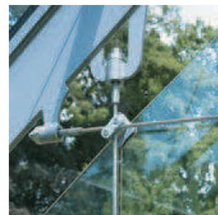
Fig.8 Ancoraggio dei cavi di facciata all'arco in acciaio.
