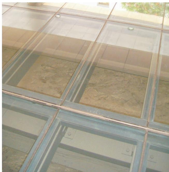
Fig.4 Dettaglio della copertura vetrata.
