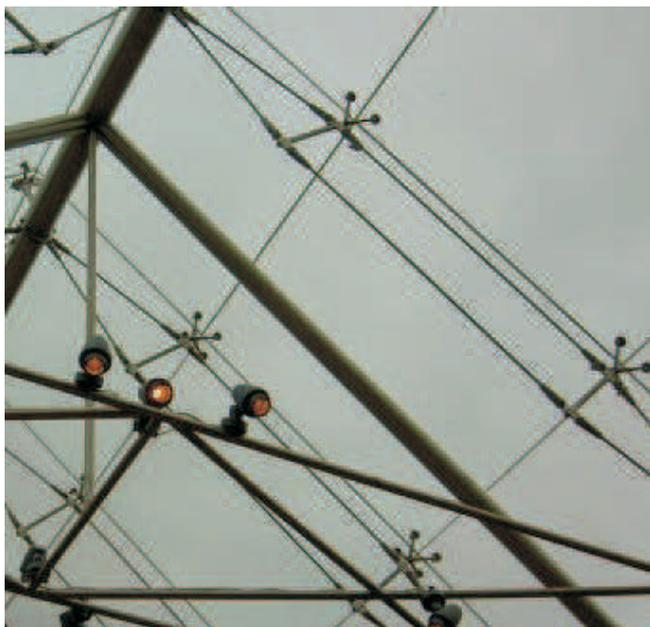
Fig.1 Vista degli elementi puntuali di ancoraggio dei vetri.
