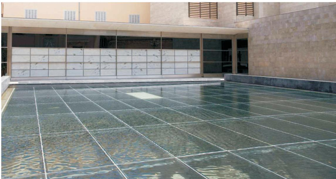
Fig. 7 - Lamina d’acqua sulla copertura in vetro a plaça de la Almoina, Spagna (foto Tricoli A.).
