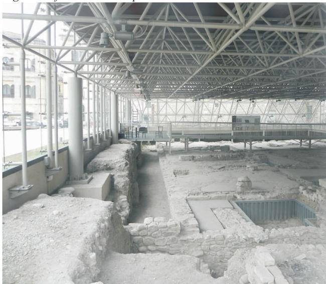
Fig.4 Vista interna della struttura reticolare spaziale in acciaio.
