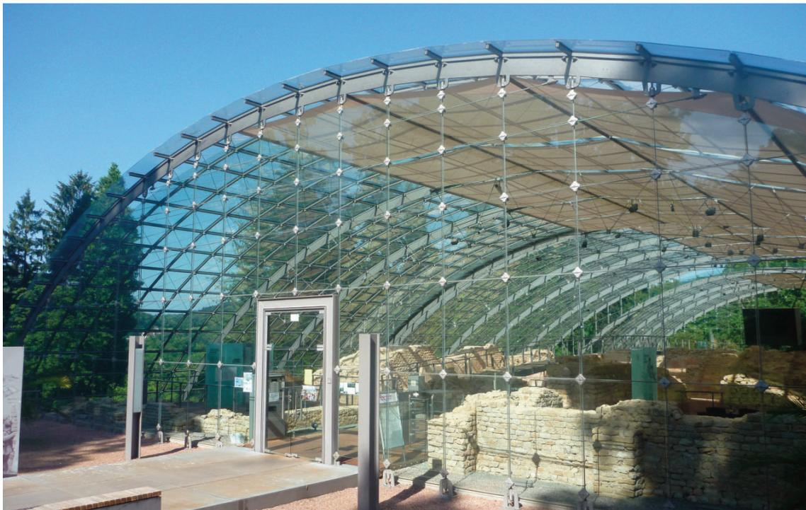
Fig. 2 - Copertura in vetro dei Resti delle Terme romane di Badenweiler, Germania. Progetto di Schlaich Bergemann und Partner, Stuttgart, 2001 (foto Lanza Volpe, A.).
