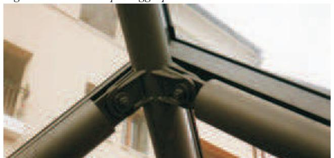
Fig.4 Dettaglio di aggancio della struttura tubolare.
