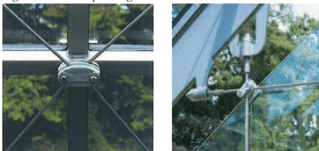
Fig.7 Cavi di rinforzo della struttura del tetto con serracavo.
