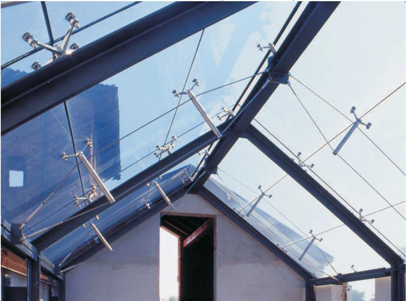
Fig.3 Dettaglio della vetrata di copertura.
