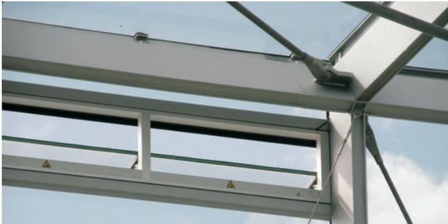
Fig.5 Vista delle aperture con lamelle in vetro.
