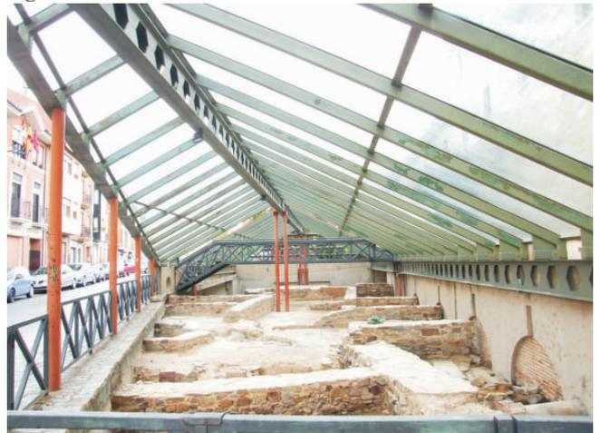
Fig.5 Vista interna della copertura con la passerella di collegamento.
