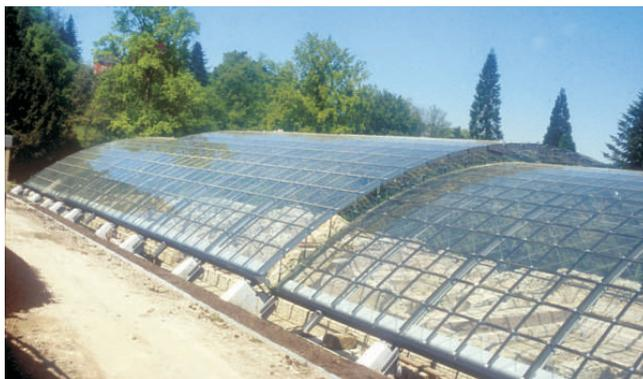
Fig.1 Vista dei plinti inclinati.
