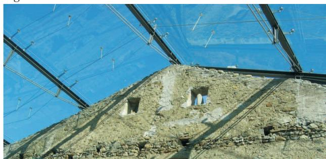
Fig.5 Vista dei cavi di tensione del tetto in vetro.
