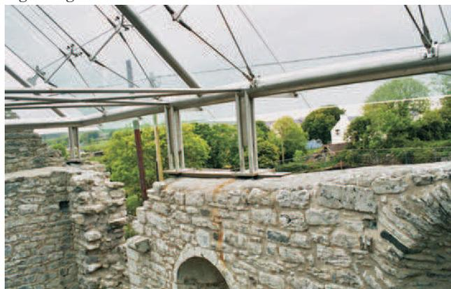
Fig.3 Vista degli ancoraggi alla struttura esistente.
