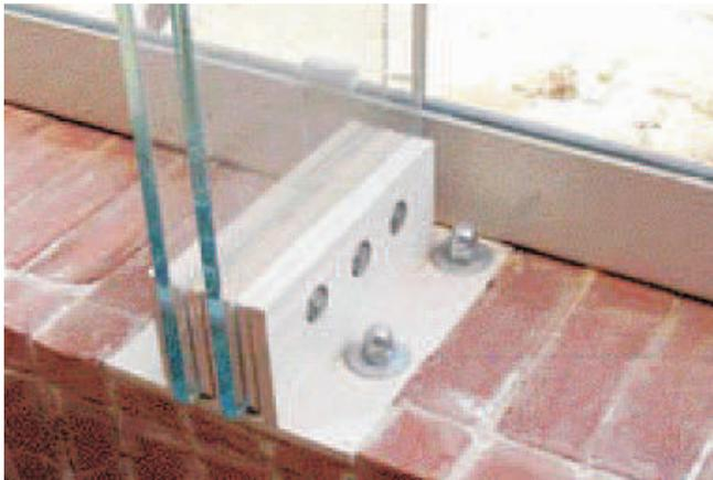
Fig.2 Piede del montante in vetro incastrato tra piastre in acciaio.
