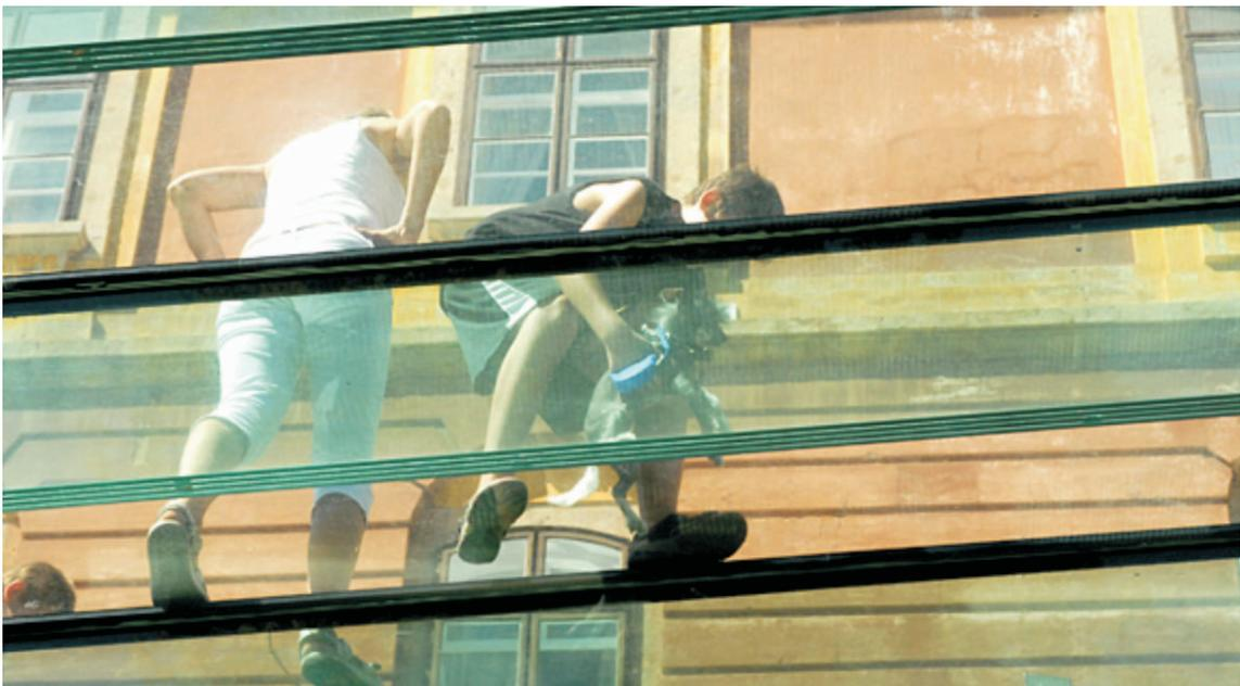
Fig. 66 - Copertura con travi portanti in vetro stratificato dell'antico cimitero paleocristiano di Pécs, Ungheria.
