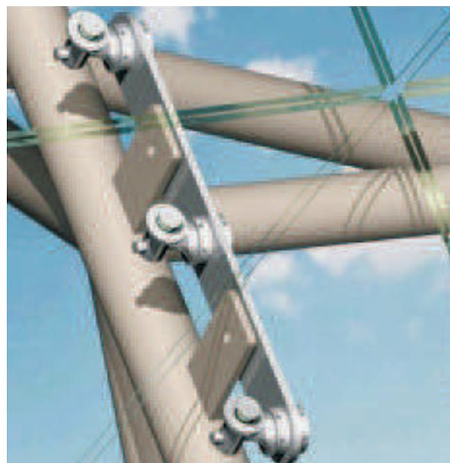
Fig.4-5 Aggancio degli elementi in vetro sulla struttura in acciaio.
