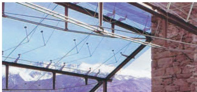
Fig.1 Vista dei cavi di tensione del tetto in vetro.
