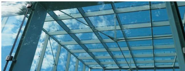
Fig.3 Cavi di irrigidimento in acciaio.
