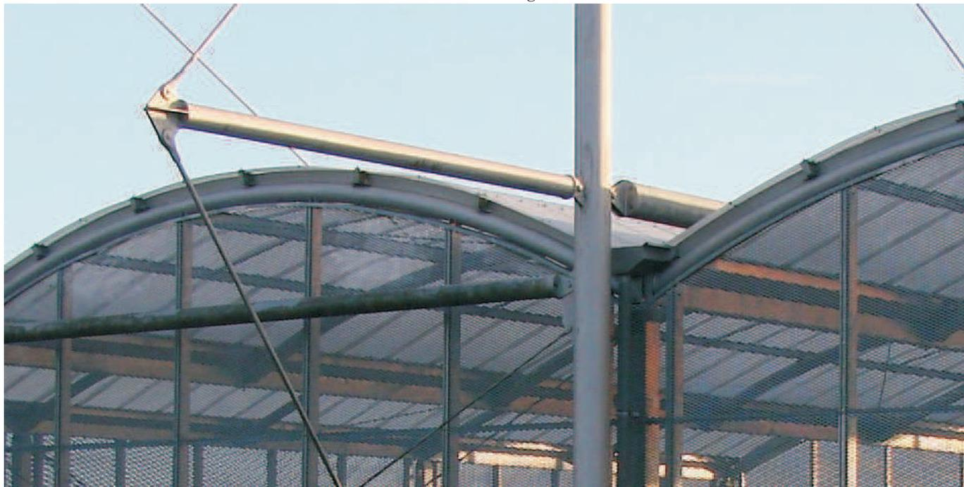
Fig.4 Dettaglio del prospetto con la rete metallica.
