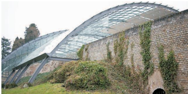
Fig.2 Vista esterna degli archi in acciaio.
