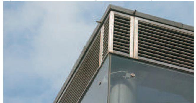
Fig.2 Vista delle lamelle di aerazione superiore.
