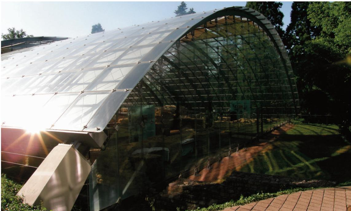
Fig. 14 - Copertura in vetro delle antiche terme romane di Badenweiler, Germania (foto Lanza Volpe, A.).
