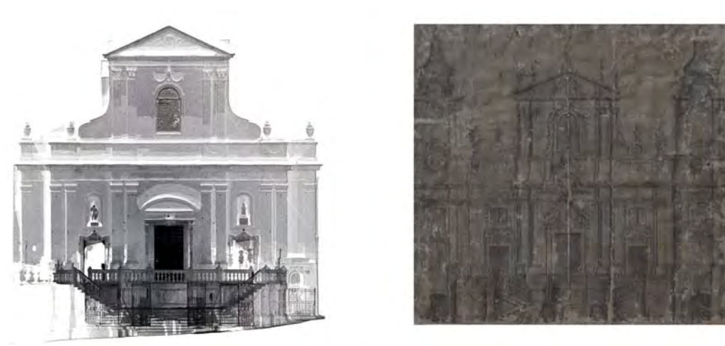
Fig. 2. A sinistra: vista della scansione laser del prospetto attuale del santuario della Madonna della Consolazione a Termini Imerese. A destra: ortofoto del progetto del 1740 relativo al prospetto.
