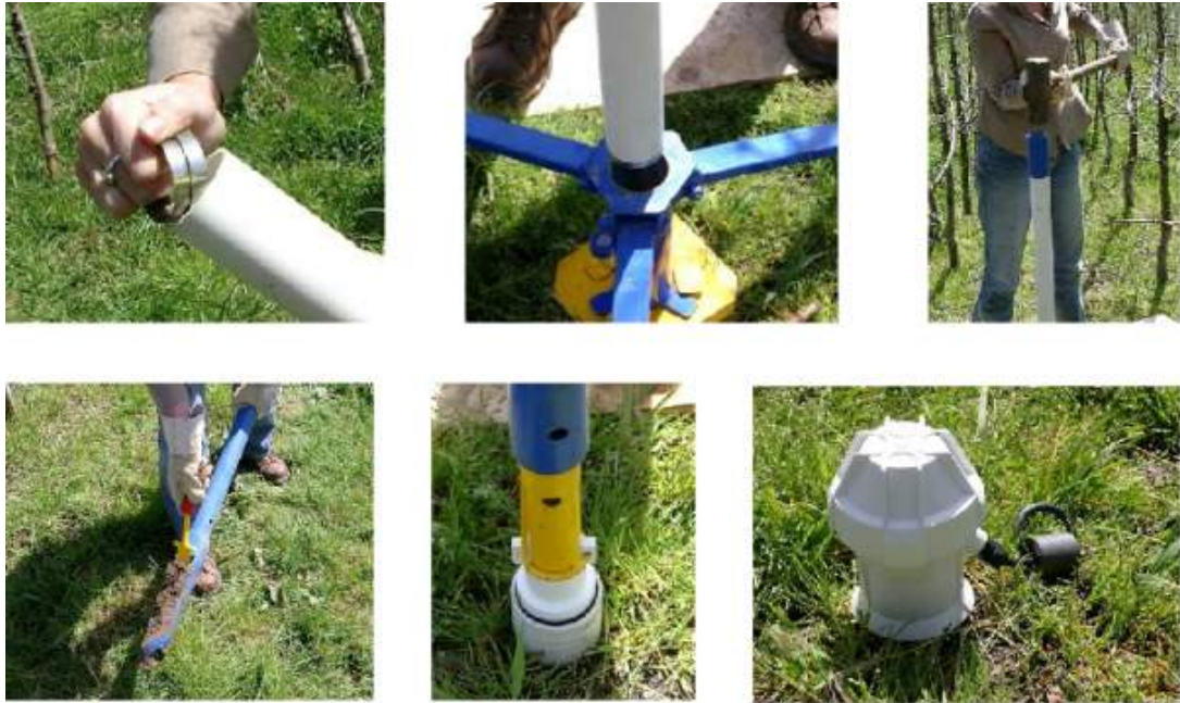
Figura 1.13 - Installazione del tubo di accesso del sensore Diviner 2000 della Sentek
