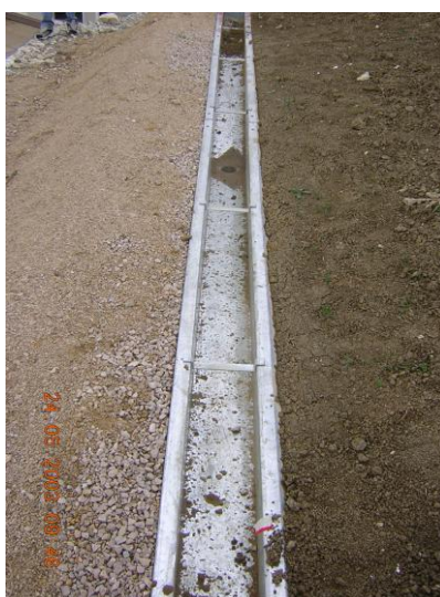
Fig. 4.1 - Vista della canaletta di raccolta
