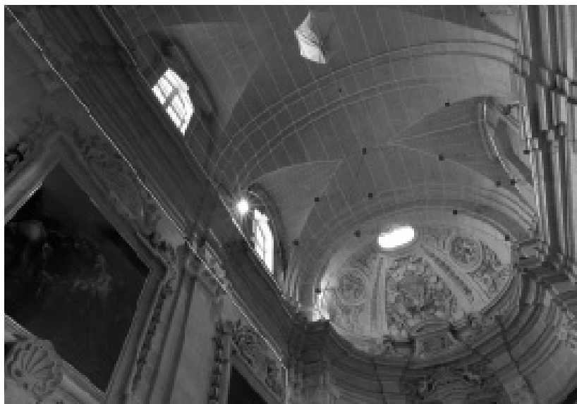
3. Costruzione del modello 3D con tecniche di fotomodellazione dell'Oratorio del SS. Sacramento presso la chiesa di Santa Caterina a Zejtun (Malta).
