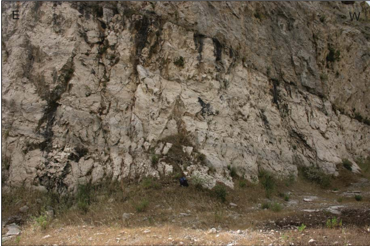
Figura 3.5 – Formazione Inici sul terzo piano di coltivazione della cava. Si vede anche il contatto con i soprastanti calcari pelagici ad ammoniti (Rosso Ammonitico) Fm. Buccheri
