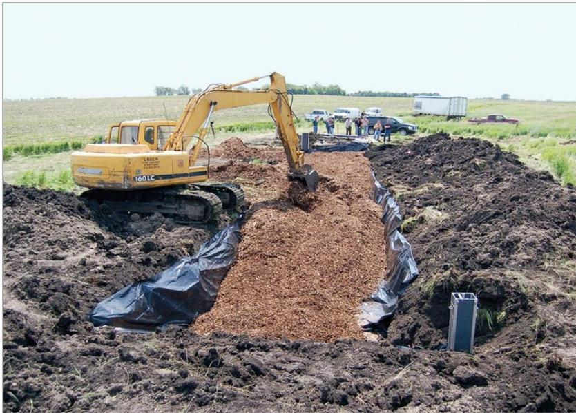
**Fig.3.6 Riempimento con segatura di legno di una PRB a trincea continua installata in Iowa (www.iasoybeans.com).**
