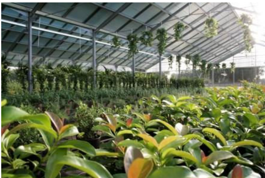
Figura 12 - Serra fotovoltaica: particolare coltivazione interna.
