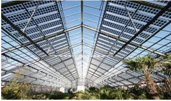
Figura 13 - Serra fotovoltaica con moduli "vetro - vetro".
