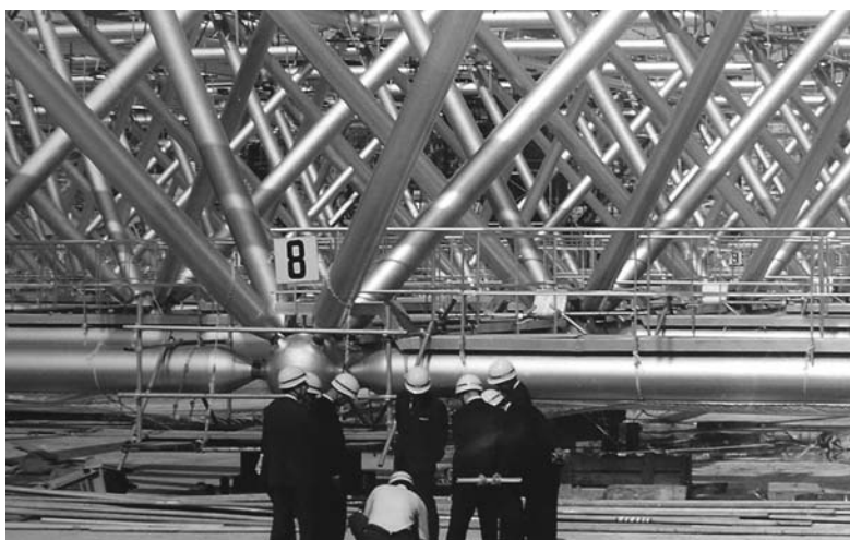
Fig. 20 - Il cantiere per la costruzione della copertura del Pavillon Plaza, 1970.
