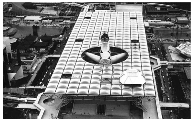
Fig. 21 - La doppia copertura in cuscini gonfiabili traslucidi, collocati nei quadrati risultanti dalla trave reticolare di copertura.
