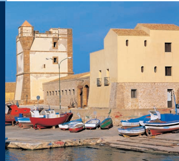
Bonagia (Valderice), l'edificio della Tonnara, XVII secolo Bonagia (Valderice), the Tuna Fishery building, 17 th century
