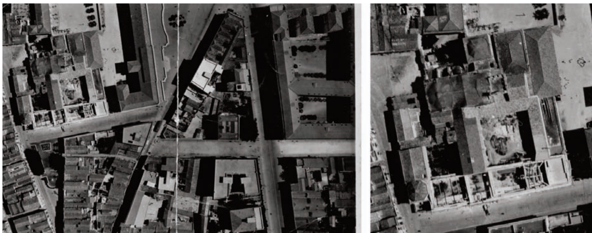
Fig. 2. Convento di San Domenico, durante le demolizioni per l'apertura della via XXIV Maggio; immagine aerea degli anni Trenta del Novecento (Archivio del convento di San Domenico). Nell'angolo sud-ovest dell'isolato è ancora visibile la copertura ottagonale dell'aula del gremio dei Calzolai.
