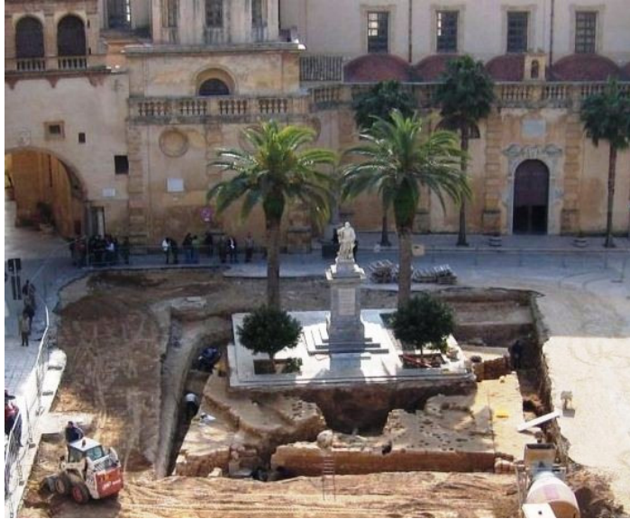
Scavi sotto Piazza della Repubblica. Strutture murarie. (Foto dal sito www.diocesimazara.it )
