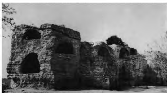
figg. 3 Arcosoli scavati lungo le mura greche.
