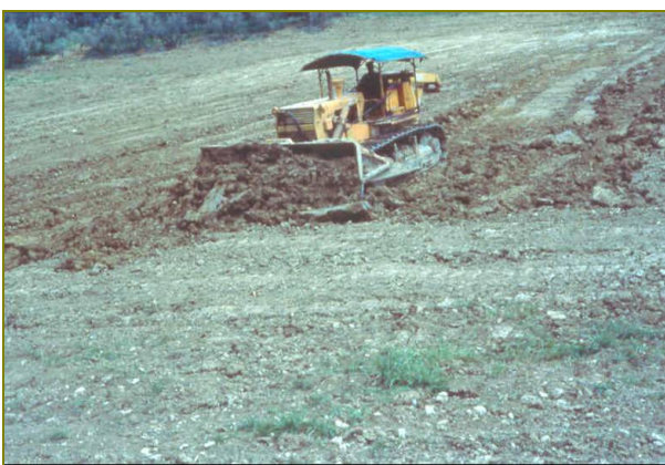
Livellamento del terreno.
