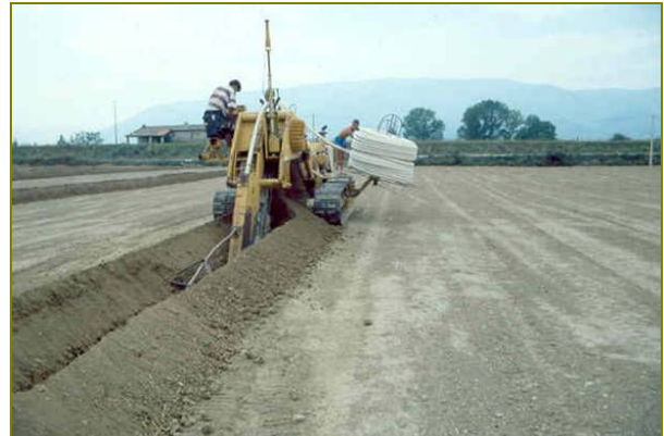
Posa in opera dei tubi di drenaggio.
