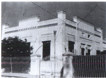
V.1.4 Villino Bertini, via del Dammuso 96/98, Sferracavallo (Palermo), 1915 ca.. Veduta dalla strada; fotografia 1989 (E. Mauro)
