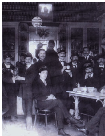
Ferrovieri al caffè della Stazione di Xirbi, nel distretto minerario di Caltanissetta; fotografia 1905 ca. (coll. privata, Caltanissetta)
