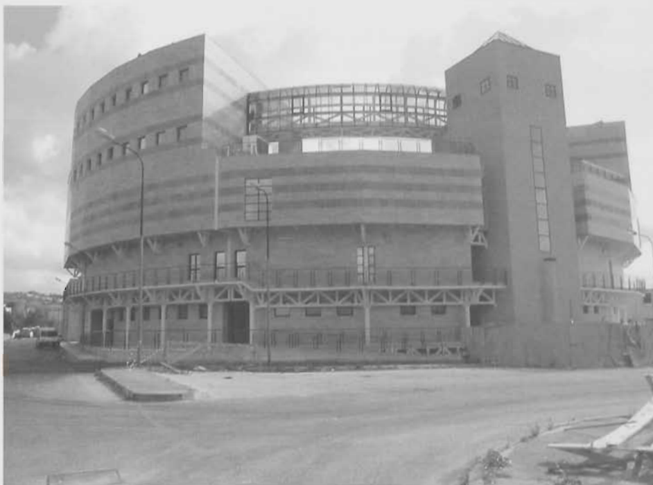
Santa Ninfa. Centro polivalente per attività produttive e commerciali (Giuseppe Realmuto con la collaborazione di Livia Realmuto, 1987, 2002 e seguenti); veduta del corpo di fabbrica principale del complesso (foto L. Realmuto, 2011).
