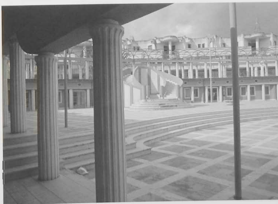
Poggioreale. Piazza Elimi (P. Portoghesi, 1986), realizzazione 1986-1991; veduta verso il complesso per alloggi e negozi del centro civico (Blocco 3 e Blocco 5) di E. Donato e E. Piroddi, 1976 e seguenti (foto L. Realmuto, 2011).
