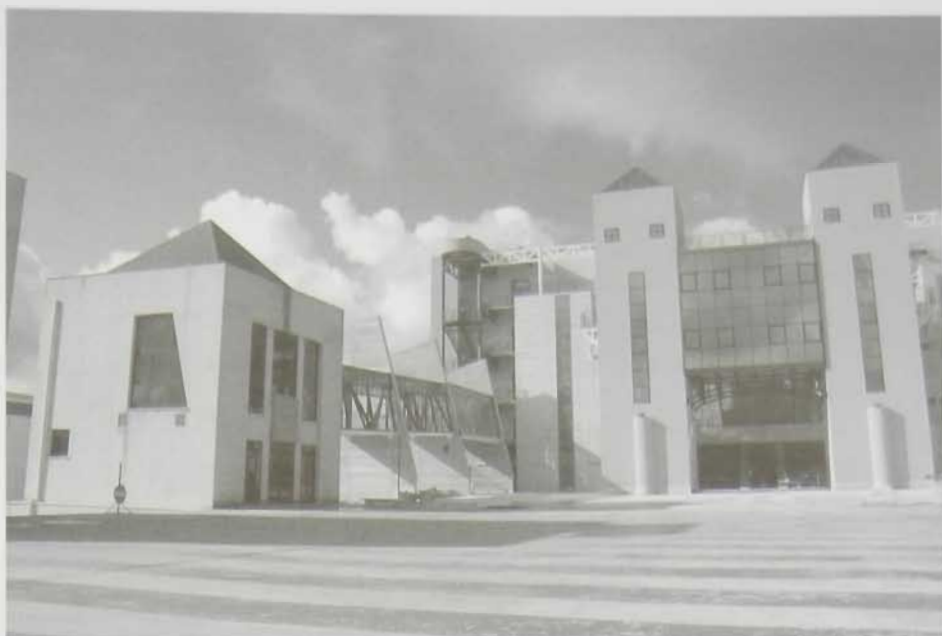
Santa Ninfa. Centro polivalente per attività produttive e commerciali (Giuseppe Realmuto con la collaborazione di Livia Realmuto, 1987, 2002 e seguenti); veduta del piazzale del complesso (foto L. Realmuto, 2011).
