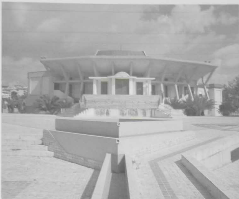
Salaparuta. Chiesa e complesso parrocchiale (G. Arca, 1976 e seguenti); veduta del ponte principale e del sagrato (foto dell'A.).
