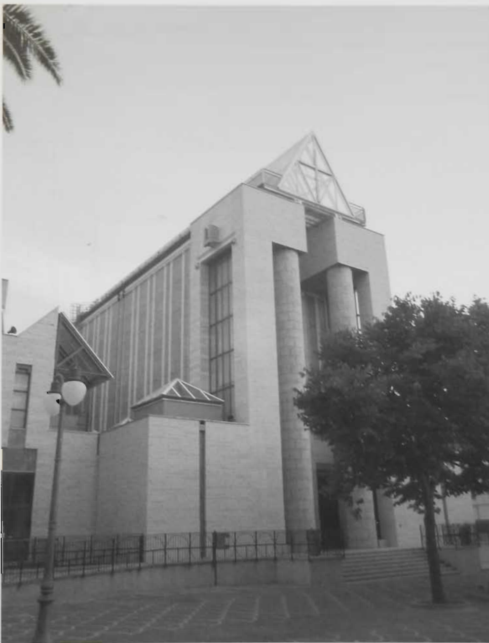
Santa Ninfa. Chiesa Madre (P. Di Stefano, 1969-1972), realizzazione 1974-2006; veduta della facciata (foto L. Realmuto, 2011).
