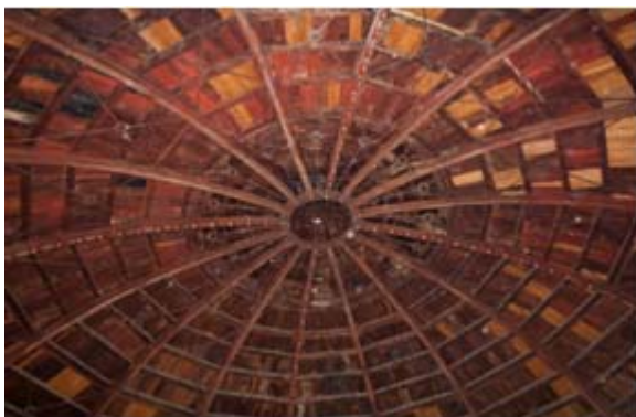
Figura 2: Vista interna della cupola
