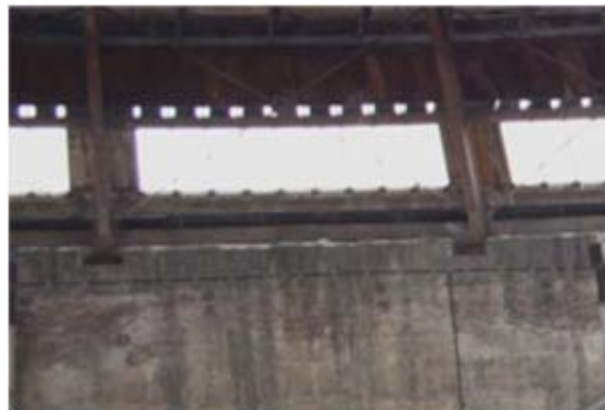
Figura 3 : Collegamento tra nervature e cordolo
