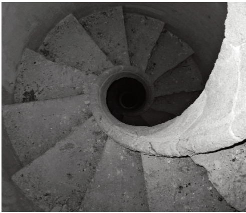
9) Palermo, Orto Botanico. Intradosso della caracol de Mallorca in pietra del Gymnasium.
