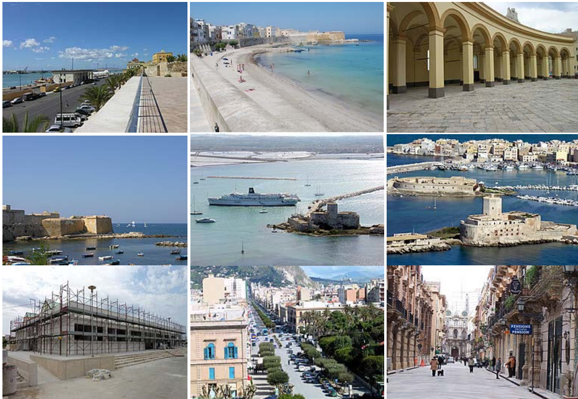
Figure 8-16 (da sinistra dall'alto). Riqualificazione della litoranea nord. Riqualificazione delle Mura di Tramontana. Restauro e rifunzionalizzazione della Piazza Mercato del Pesce. Restauro del Bastione Conca. Il canale Ronciglio, ingresso dal mare alla riserva delle Saline. Il castello della Colombaia, recuperato e destinato a funzioni culturali. Il centro servizi per la mobilità a Piazzale Ilio, in corso di costruzione. Riqualificazione dell'asse viario di Via Fardella della città del XX secolo. Riqualificazione del Corso Vittorio Emanuele in centro storico.
