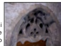
Fig. 6.57 - A destra, alcune immagini della monofora allo stato attuale rinvenuta durante i lavori di restauro del 1995.
