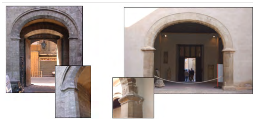
Fig. 6.31 - Palermo, Palazzo Ajutamicristo, fornice di ingresso, Palazzo Abatellis fornice di ingresso al cortile.
