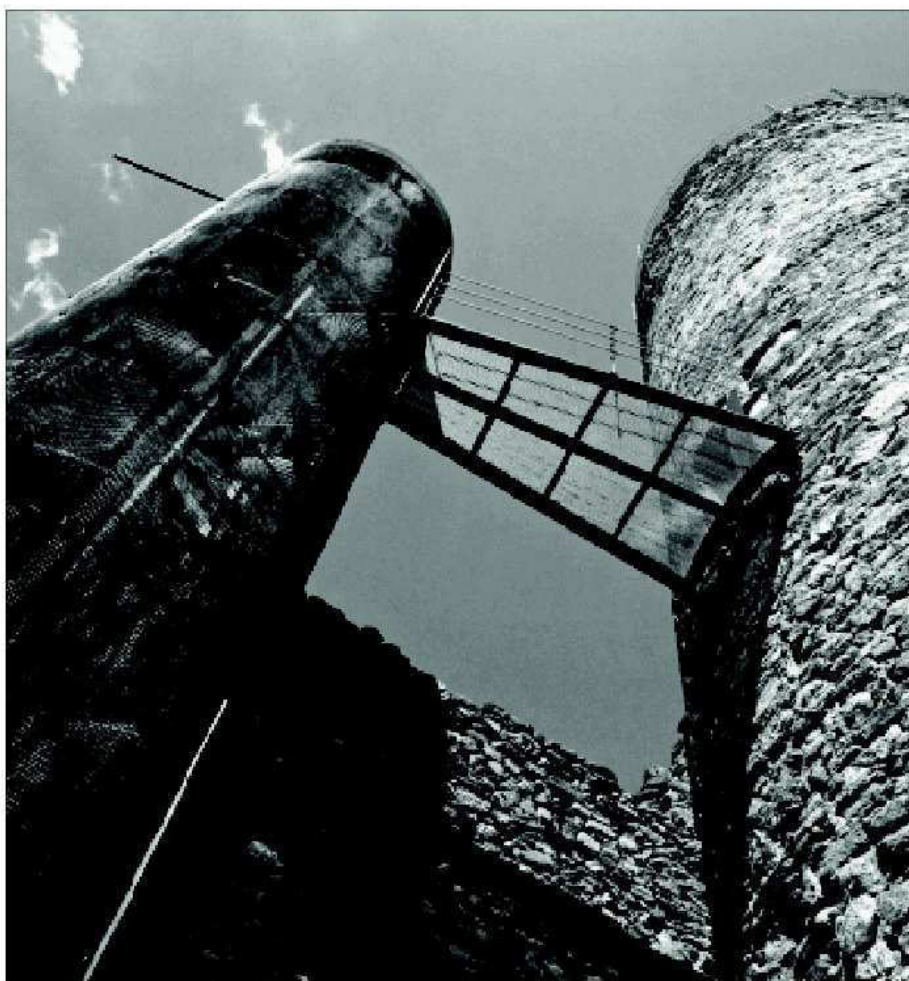
16) Werner Tscholl, Castello di Reichenberg a Tubre (Bolzano), 1998-2000.
