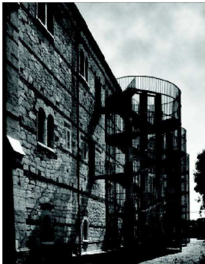
15) Ivano Stardi e Progetti-Massimo Carmassi, Restauro del Silos di Ponente a Verona, 2009.
