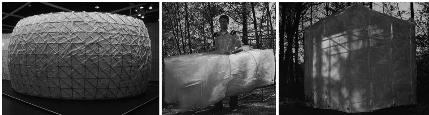
■ 12. Vacuomatics , strutture pneumatiche sottovuoto: a sinistra, Mero trade-fair stand (2002); a destra, Tea Pavilion (2007), Maasaki Iwamoto, Ilek Student Project (da "Detail" n. 10, Monaco 2007, p. 1148 e p. 1158).
