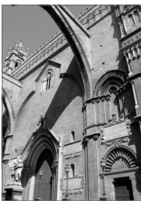
fig.3 Palermo. Cattedrale, in primo piano gli archi che contrastano le spinte delle navate.
