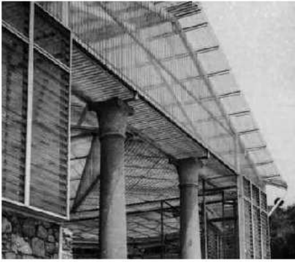
1) Piazza Armerina, Villa del Casale: la copertura protettiva
