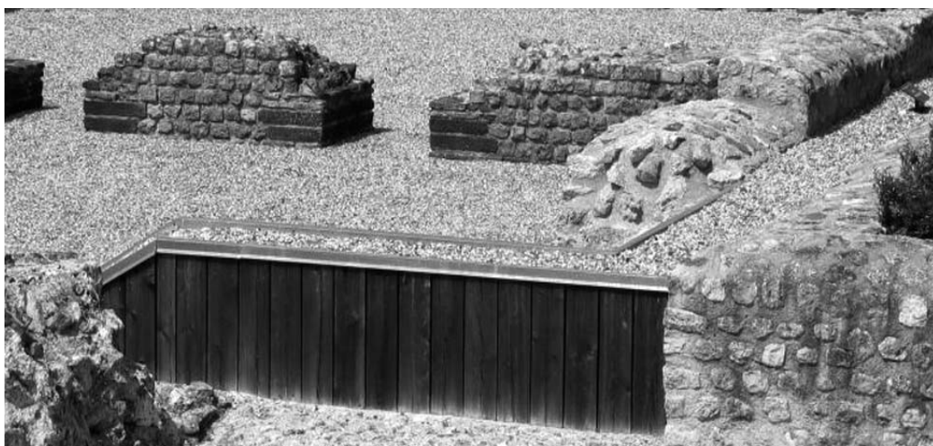
Un dettaglio del collegamento dei paramenti in legno con le murature preesistenti.
