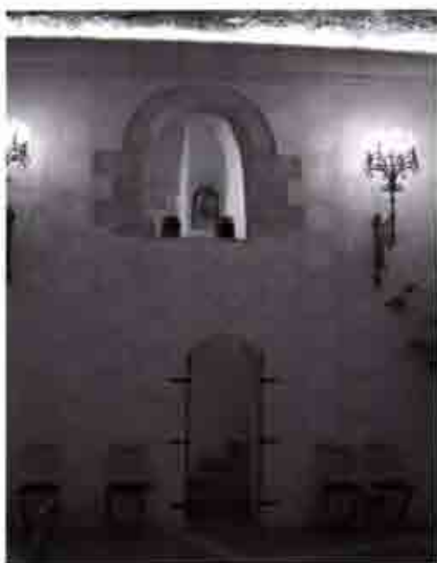
La Torre dopo gli interventi degli anni '80.
